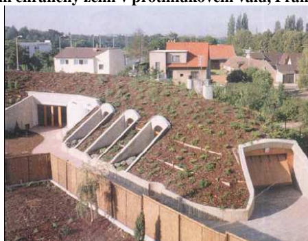
Obr. 3: Dům chráněný zemí v protihlukovém valu, Praha –Smíchov.
