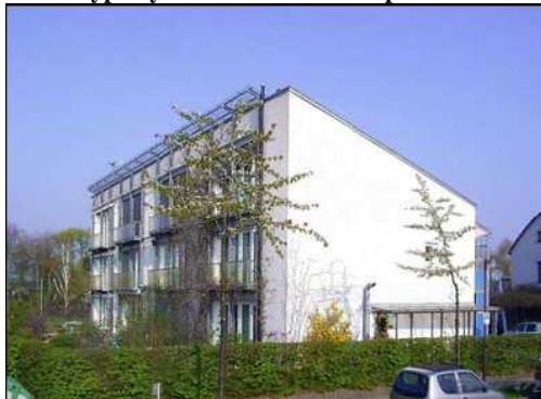
Obr. 2: Typický vzhled nadzemního pasivního domu.
