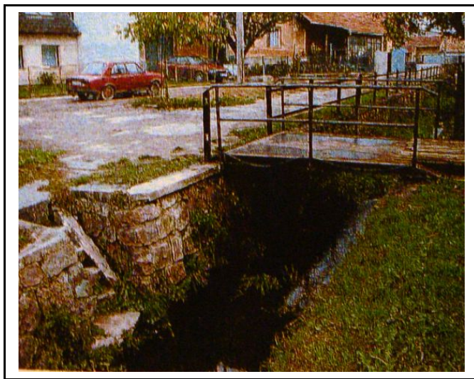
Obr.č.6 : Ocelový mostek obci (pohled proti vodě) ř.km 5,342
