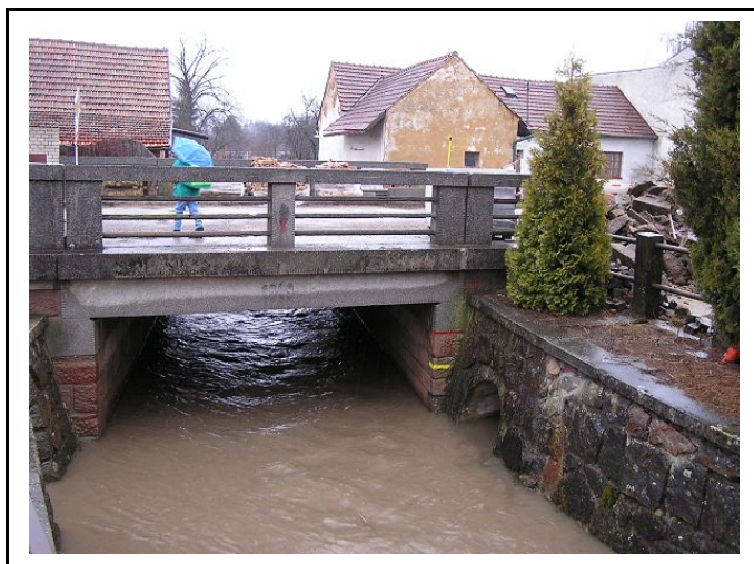
Obr.č.7 : Silniční most v obci (pohled proti vodě) ř.km 5,414
