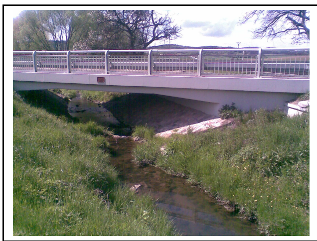
Obr.č 11.: Silniční most v km 6,325
