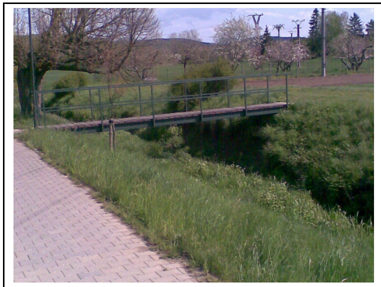
Obr.č.9 : Dřevěná lávka pro pěší (pohled proti vodě) ř.km 5,842
