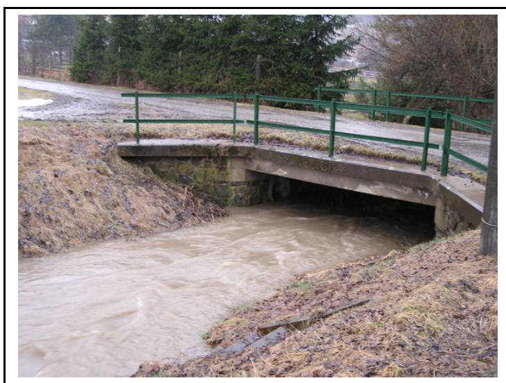
Obr.č.10 : Betonový most (pohled proti vodě) v ř.km 6,172
