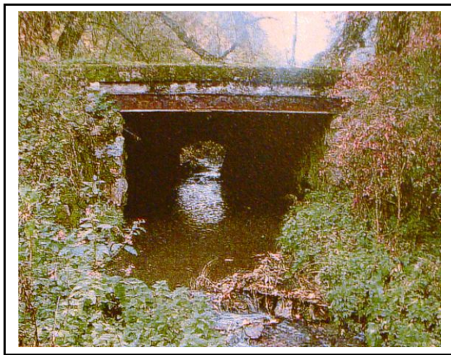
Obr.č.4 : Hospodářský most (pohled proti vodě) ř.km 4,481
