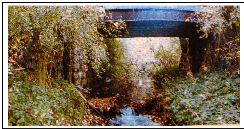
Obr.č.3 : Hospodářský most (pohled proti vodě) ř.km 3,928
