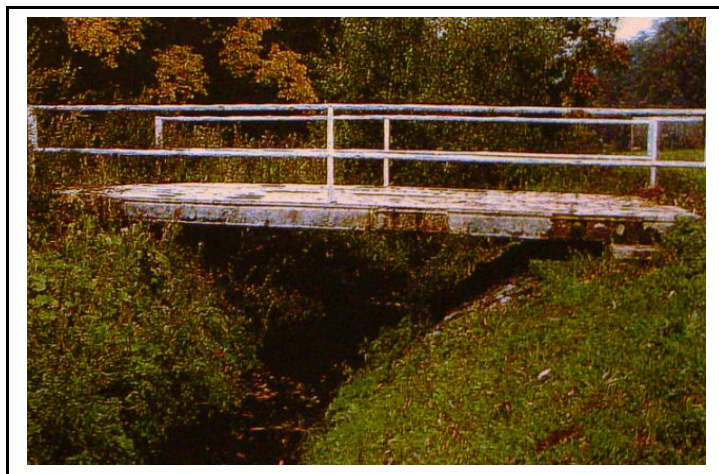
Obr.č.5 : Hospodářský most (pohled proti vodě) ř.km 5,046
