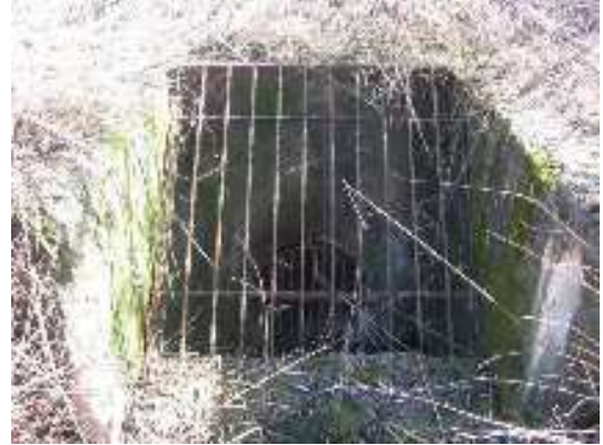
Obr. 40 Stávající výpustný objekt
