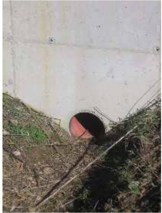
Obr. 33 Detail propustku - DN 400
