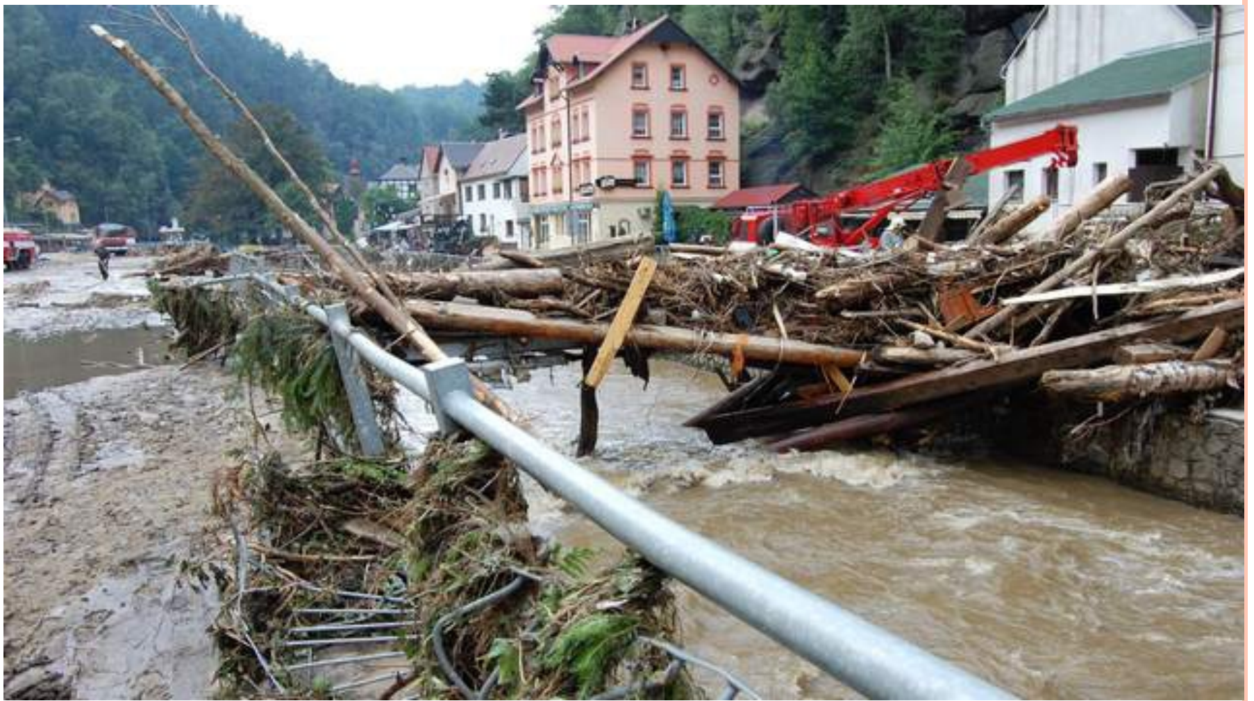
Povodně Hřensko, srpen 2010
