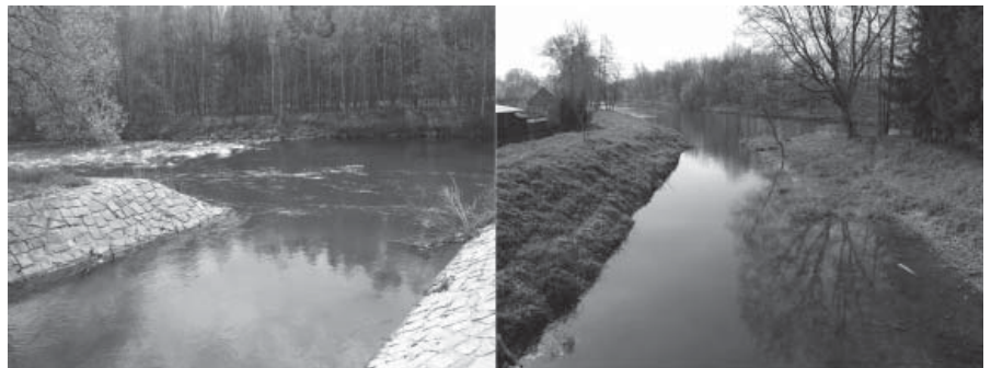
Nový kamenný stupeň v řece Moravě (vlevo) má zajistit natékání vody do Zámecké Moravy. Jeho vybudováním nevznikla zásadní újma, neboť v tomto úseku je Morava upravená, stupeň je z kamene a je dobře migračně prostupný. Podle mnohých názorů měl být vyšší. V popředí je nátok do Zámecké Moravy, na nějž navazuje stavidlo a mostek. Vpravo je pak zaústění zpět do Moravy
