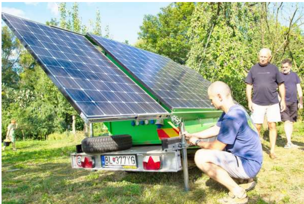
Ukázka ostrovní fotovoltaiky při Jablečné slavnosti
